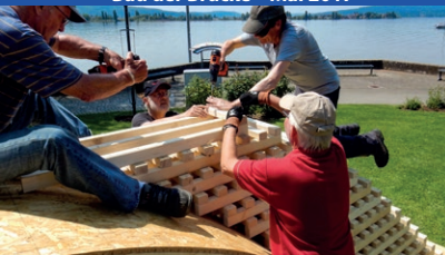
Bau der Brücke – Mai 2017
